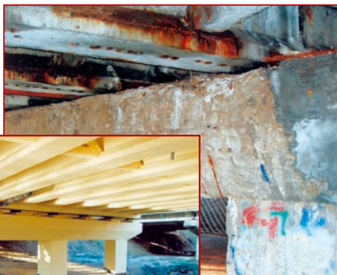
Zdj. 3b Widok mostu po wykonaniu przebudowy podpór i ustroju nośnego
