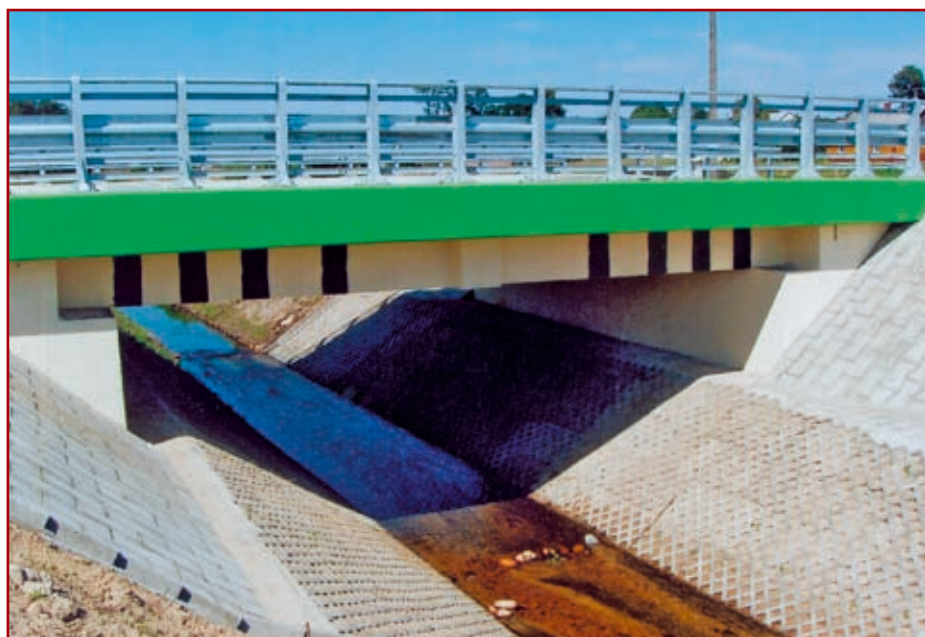
Zdj. 2 Widok z boku – wzmocnienie żurawicy głównej matami CFRP
