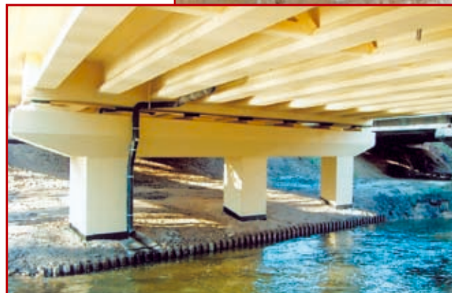
Zdj. 3b Widok mostu po wykonaniu przebudowy podpór i ustroju nośnego
