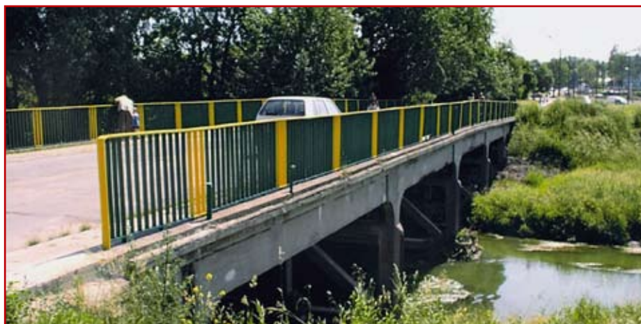
Zdj. 4. Most wybudowany przez inż. M. Lutosławskiego w 1908 r. na Kalinowszczyźnie
