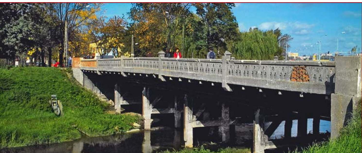
Zdj. 1. Widok mostu w ciągu ulicy Zamojskiej w Lublinie (2002 r.)
