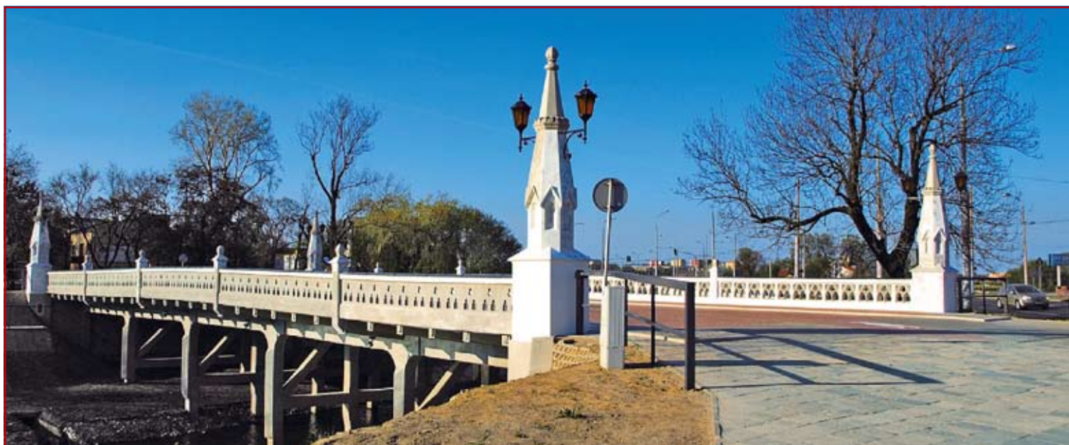
Zdj. 2. Most w ciągu ulicy Zamojskiej w Lublinie po remoncie (2012 r.)
