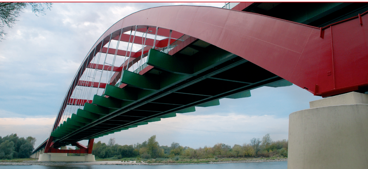
3. Most w Puławach jest jednym z pierwszych całościowo monitorowanych obiektów w Polsce. Ze względu na dużą rozpiętość przęsła nurtowego, przęsło zostało wzmocnione konstrukcją łukową
