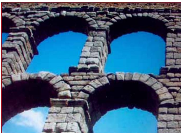
Rys. 2. Akwedukt w Segowii. Układ bloków kamiennych układanych bez zapraw
