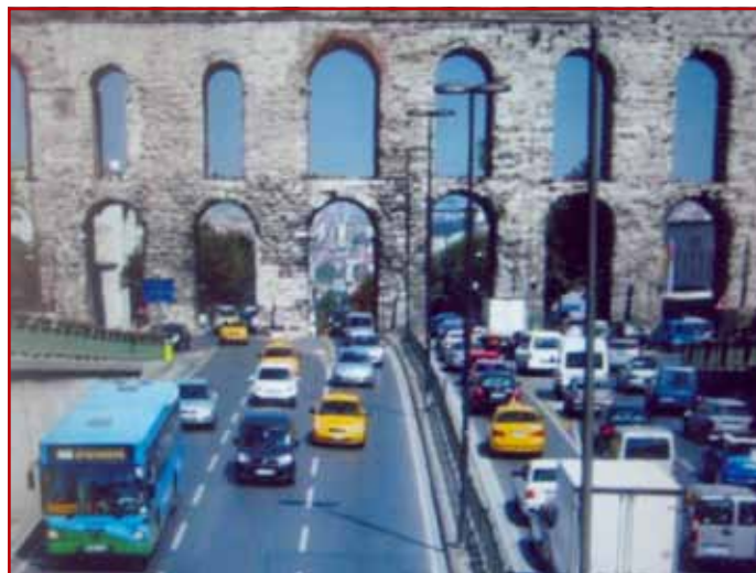
Rys. 4b. Akwedukt Walensa. Rok budowy 364-378 r. n.e. Współczesny ruch drogowy
