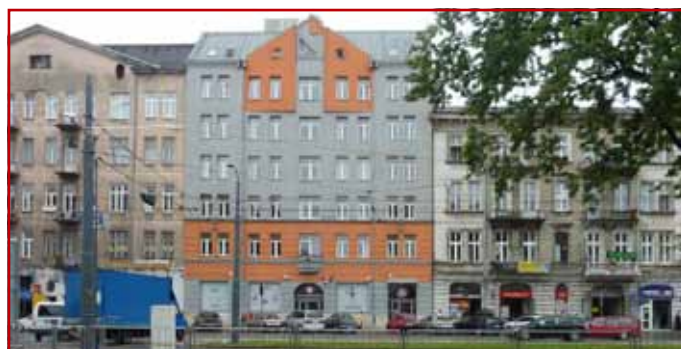
Rozbudowa i modernizacja siedziby Głównego Inspektoratu Sanitarnego przy ul. Targowej 65 w Warszawie, wraz z pierwszym wyposażeniem
