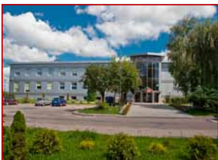
Instytut Agrofizyki PAN im. B. Dobrzańskiego – modernizacja budynku przy ul. Doświadczalnej 2-4 w Lublinie
