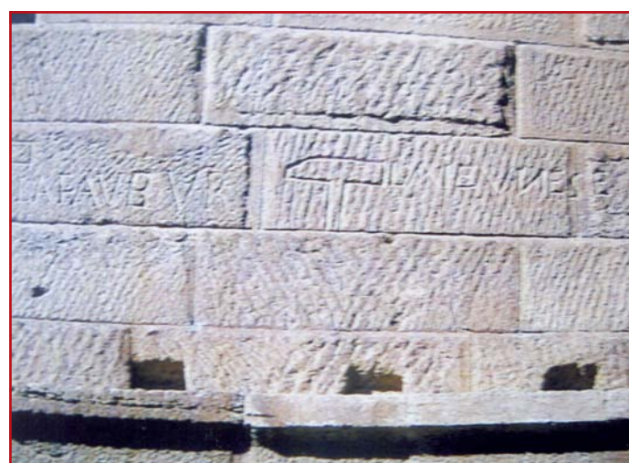
2a i 2b. Bloki kamienne, z których wzniesiono konstrukcję Pont du Gard
