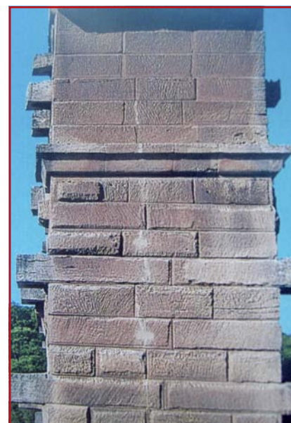
3. Układ ciosów w sklepieniach Pont du Gard
