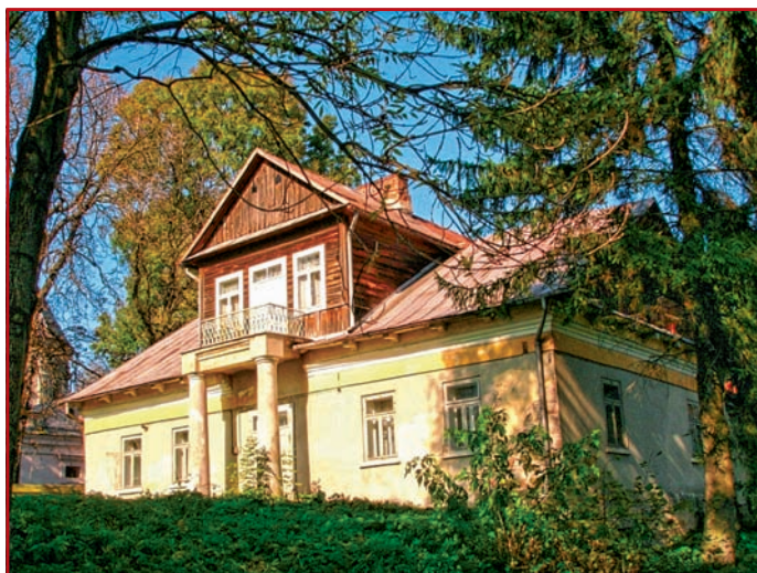
Rys. 1. Elewacja południowo-wschodnia starej plebanii w Wojsławicach (2010 roku)
