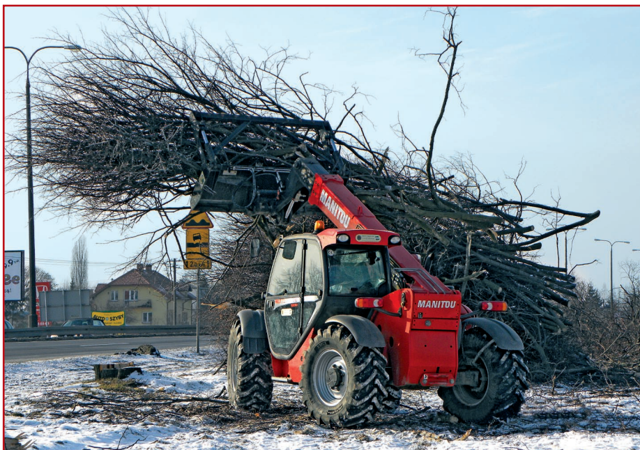
Prace przy budowie S17. Fot. Wł. Skonecki
