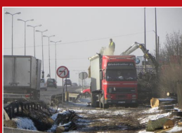
Budowa drogi S17 Kurów – Lublin – Piaski
