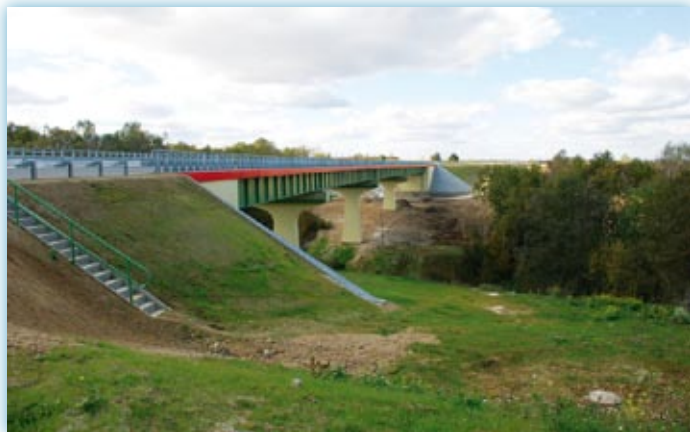
Widok ogólny estakady – obiekt nr III
