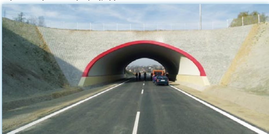
Tunel pod drogą gminną nr 108374L – ul. Piaseczna
