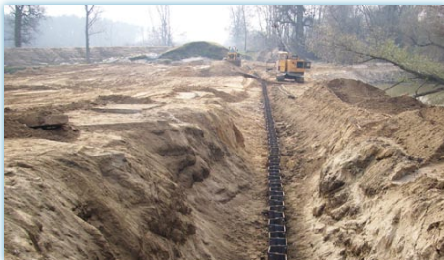
Zabijanie ścianki szczelnej w m. Popów
