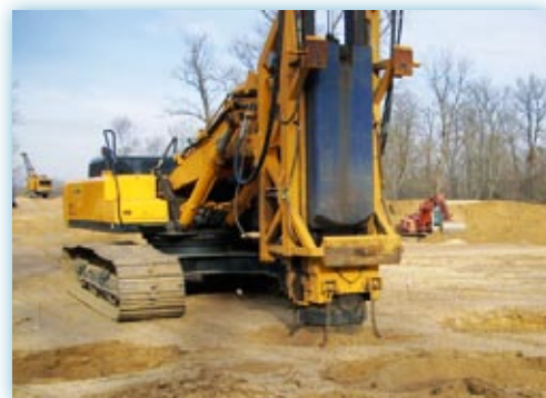
Zagęszczanie darowe impulsywne podłoża pod odbudowywany wał w m. Popów
