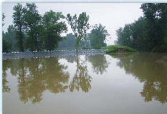
Wykonany wał opaskowy w m. Popów
