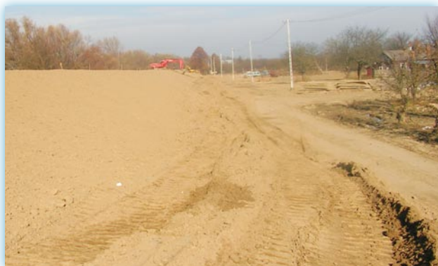
Odbudowywany wał w m. Zastów Polanowski
