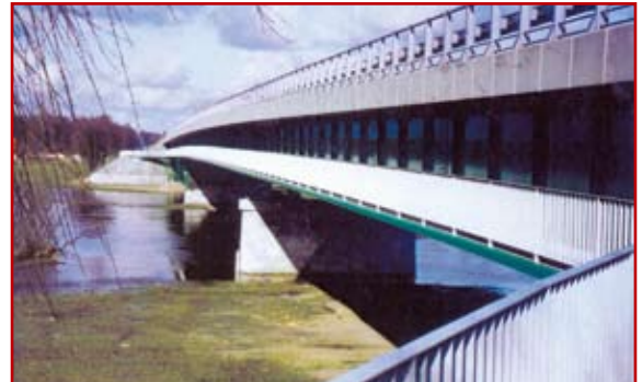
Widok mostu po przebudowie w 2001 r.
