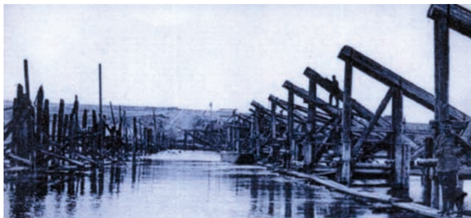
Rys. 1. Zniszczony most na Wiśle w Rachowie k/ Annopola rok 1915. Arch.
