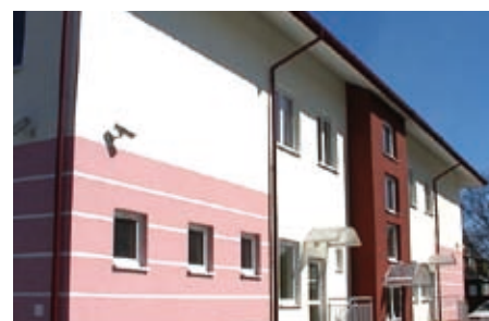
Budynek przychodni N.Z.O.Z. „LEK – DENT” w Chełmie
