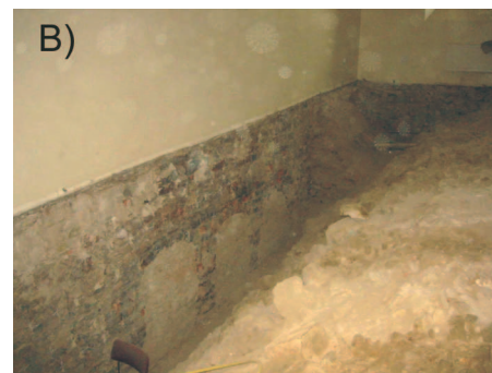
Fot. 3 Sala Unii Lubelskiej w czasie remontu: A) kamienne sklepienie nad piwnicą, B) w oczyszczonych pachwinach sklepienia na ścianach odkryte zostały zamurwane otwory
