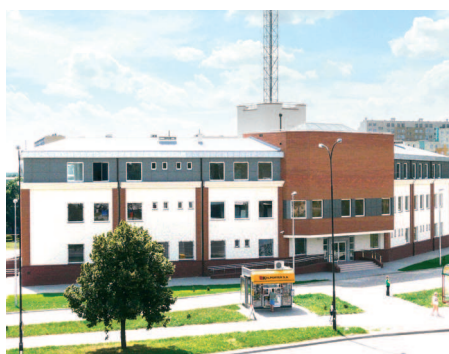
Budynek Komisariatu IV Policji przy ul. T. Zana w Lublinie
