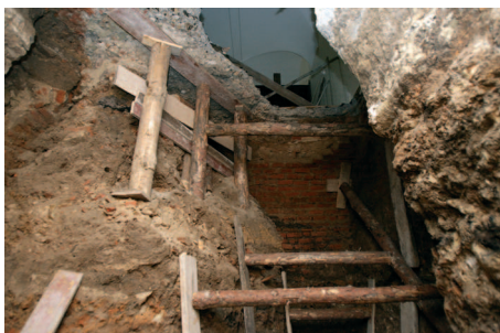
Zabezpieczenia przez osunięciem
