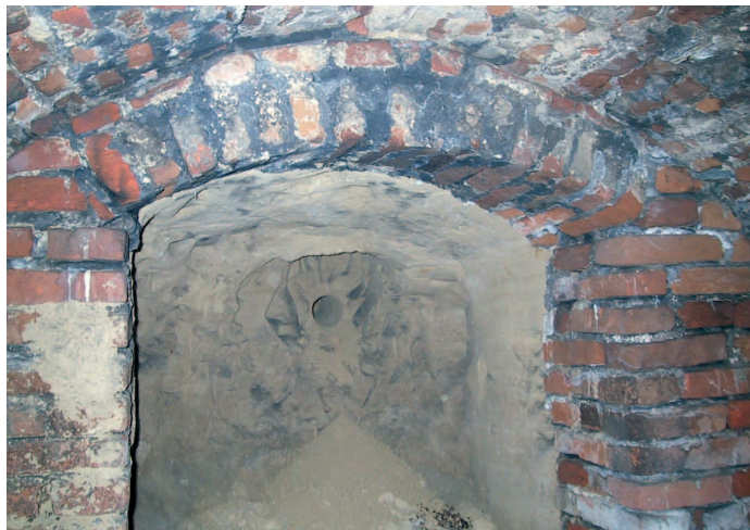
Fot. 4 Otwór w ścianie szczytowej piwnicy drugiego poziomu skrzydła wschodniego, znajdującej się pod ścianą zewnętrzną budynku
