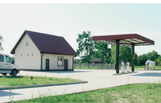
Stacja benzynowa w Kolonii Łowcza
