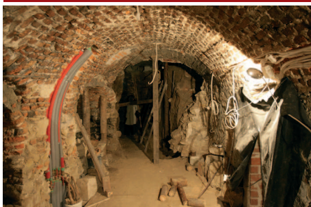
Prace w piwnicach trwają
