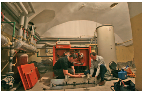
Montaż instalacji grzewczej
