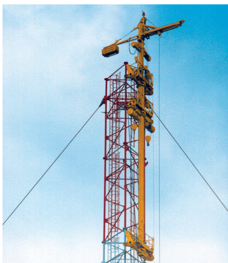
Maszt radio-telewizyjny. Montaż trzonu za pomocą żurawia pełzającego ŻP-8
