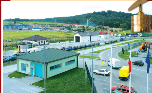
Drogowe przejście graniczne w Hrebennem po rozbudowie
