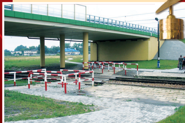
Przebudowana droga krajowa Nr 12 na odcinku Piaski – Dorohucza z obiektami inżynierskimi
