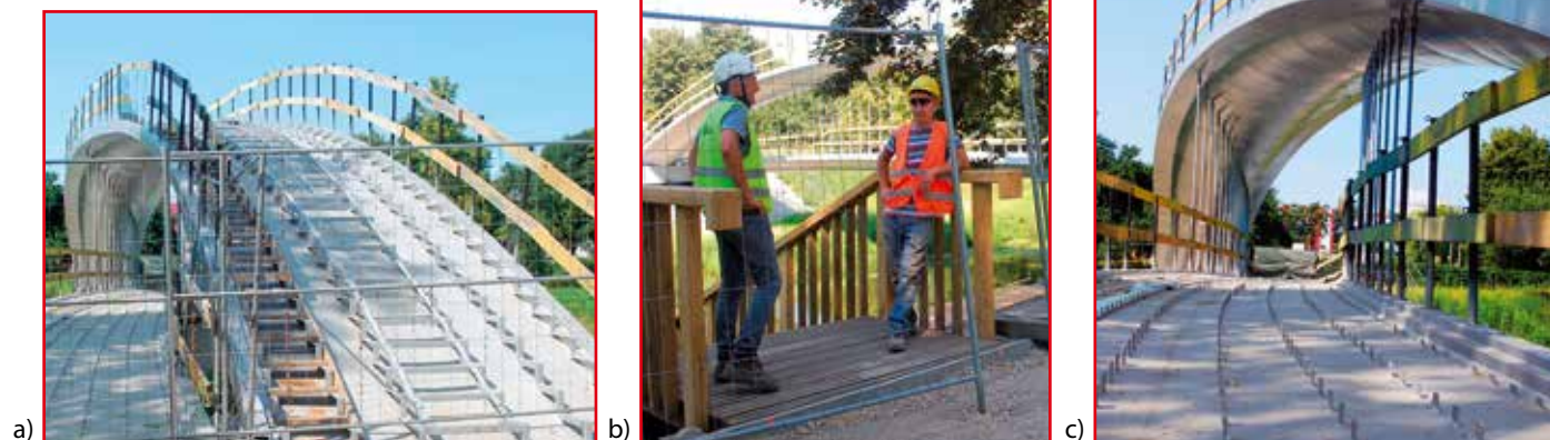
Rys. 12. Sierpień 2020 r.: a) kładka zabezpieczona srebrną powłoką ochronną; b) omówienie zadań na budowie; c) widok na górny pomost
