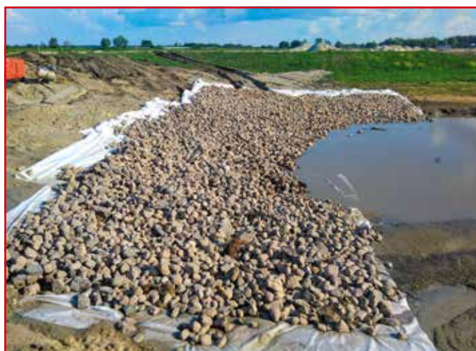
Fot. 4. Umocnienie skarpy odwodnej narzutem kamiennym w strefie wahań wody
