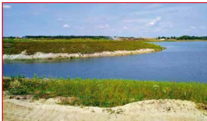
Fot. 3. Wyspa w czasie zbiornika o powierzchni 0,72 ha
