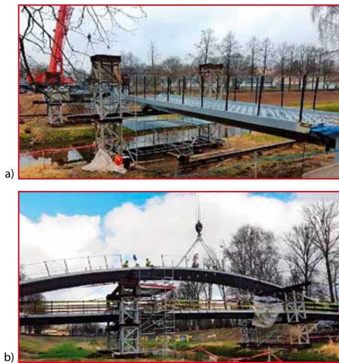
Rys. 8. Montaż i scalenie kładki na przyczółkach: a) zmontowany pomost dolny; b) podpory tymczasowe do pomostu górnego
