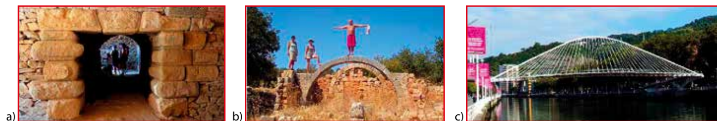
Rys. 2. Łuki: a) łuk płaski (nadproże), Mérida; b) kamienny łuk kołowy, okolice Tarsus, Turcja ~2. w. p. n. e.; c) Zubizuri, hybryda trójkąta z łukowym górnym wierzchołkiem, Bilbao, 1997 1 .
