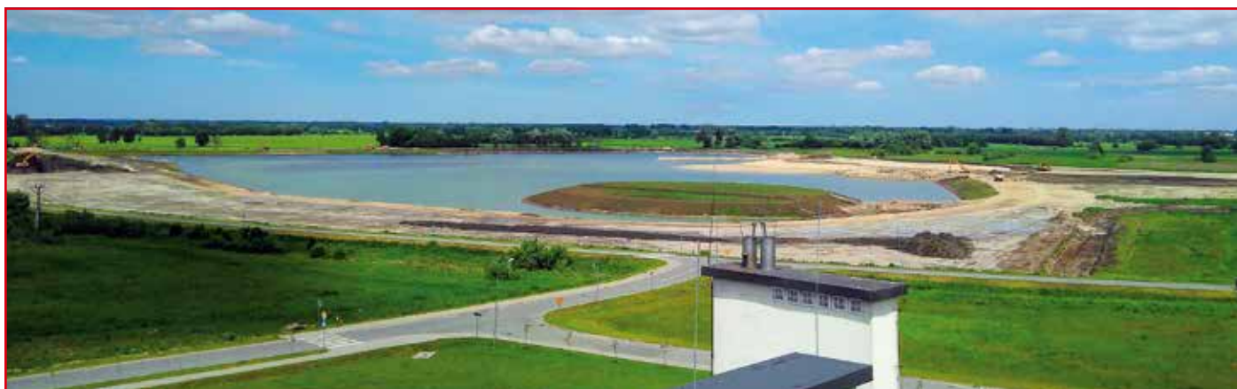
Fot. 1. Zbiornik retencyjny z wieży widokowej budynku Urzędu Gminy Terespol w Kobylanach
