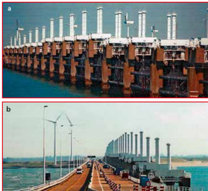
Rys. 10. Zapora po zakończeniu budowy: a. w trakcie eksploatacji na morzu, b. most drogowy, stanowiący element konstrukcyjny zapory
