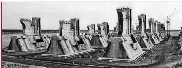
Rys. 5. Filary zapory po wykonaniu przygotowane do transportu
