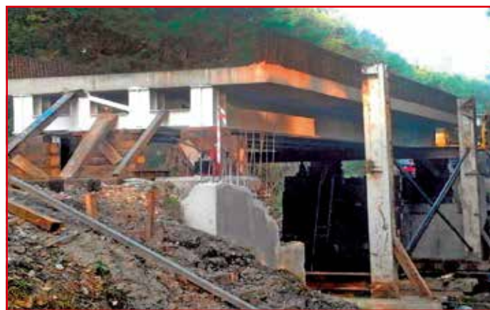
Rys. 5. Zdjęcie konstrukcji wsporczej do ustawienia ustroju nośnego na łożyskach
