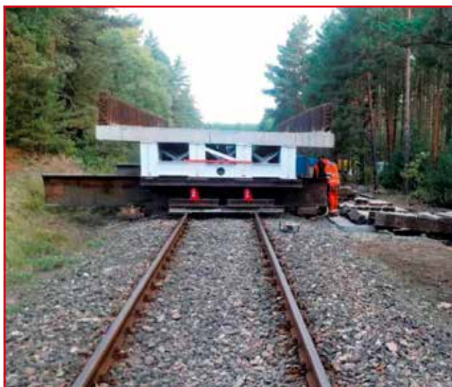
Rys. 4. Prace w miejscu A; a) widok na przęsło mostowe; b) tymczasowa rampa montażowa, zespolony ustrój nośny przed przesunięciem poprzecznym; c) pozycja przęsła, wraz z platformą, po przesunięciu poprzecznym, gotowa do ustawienia na wózkach
