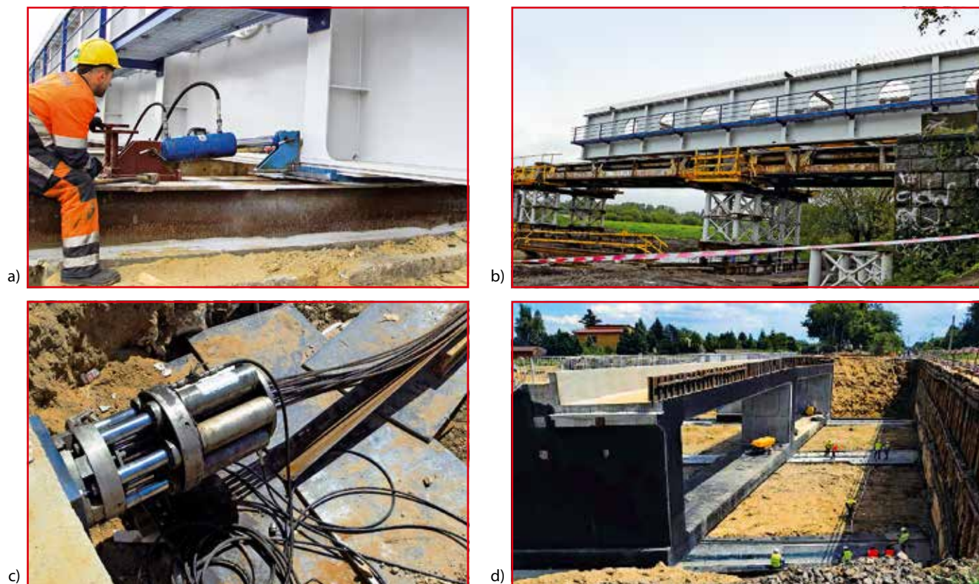
Rys. 1. Nasuwanie mostów: a–b) nasunięcie poprzeczne i podłużne ustroju nośnego typu Vierendeel'a, 2008 r.; c–d) nasunięcie/przeciągnięcie ramowego ustroju nośnego wiaduktu kolejowego nad S19, 2016 r.
